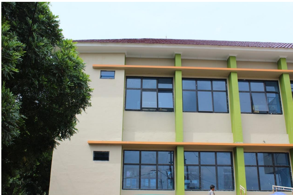
Gambar 2.4 Pembangunan Ruang Kelas Baru (RKB)
