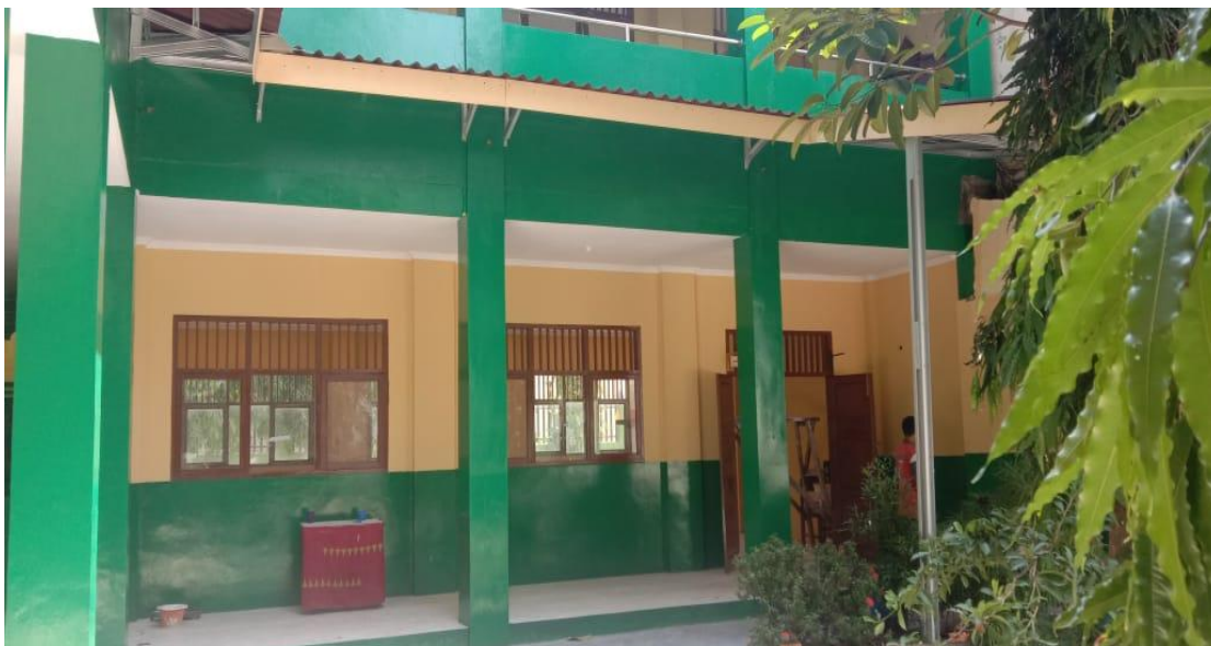
Gambar 2.8. Pembangunan Ruang Kelas Sekolah
