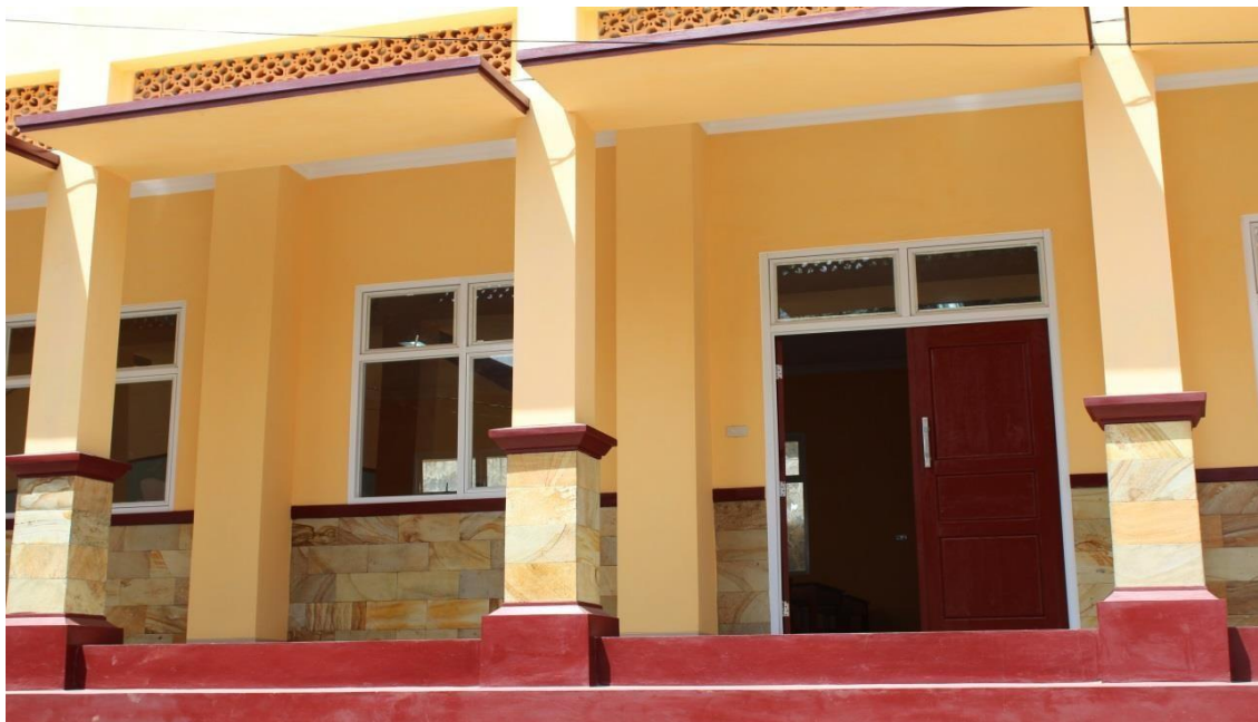
Gambar 2.5 Pembangunan Ruang Kelas Baru (RKB)
