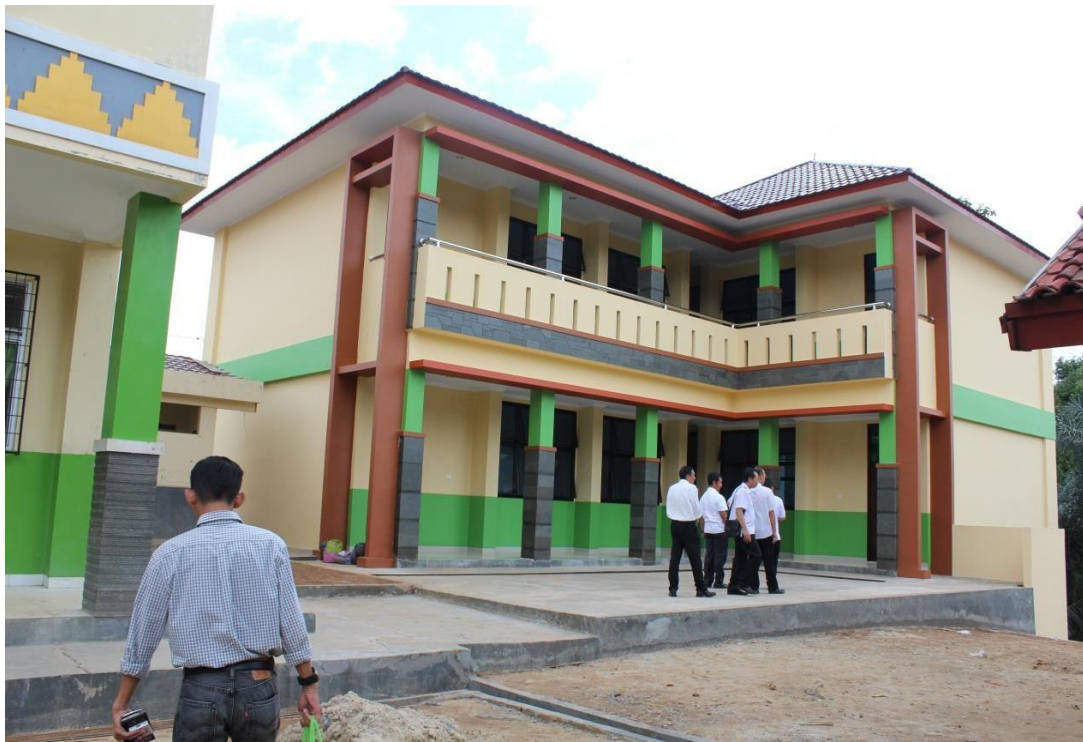
Gambar 2.3 Pembangunan Ruang Kelas Baru (RKB)
